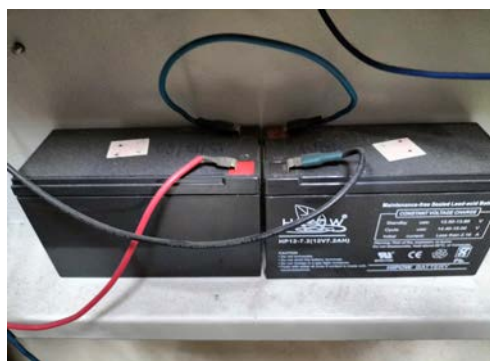
Batter Back Up ตู้FCP ขนาด 12V 7.2AH = 2 ea
