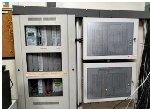
รูปการตรวจเช็คตู้ Fire Alarm Control Panel / Graphic Annunciator
