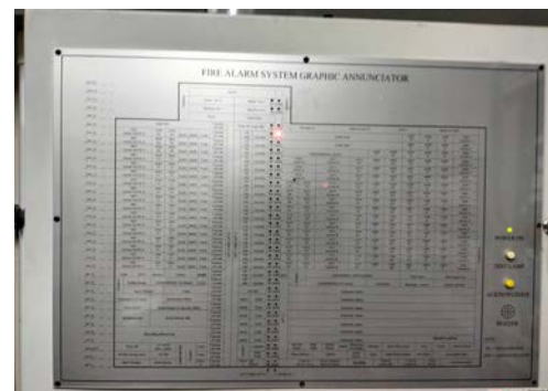
รูปการตรวจเช็คตู้ Fire Alarm Control Panel / Graphic Annunciator
